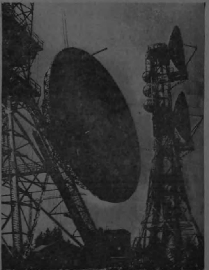
Un espejo suspendido contra el cielo. Pesa diez toneladas el espejo de radio orientación de 18 metros de diámetro que se enarbola aquí sobre la torre del Torfhausberg de 820 m., de altitud en el Harz.
